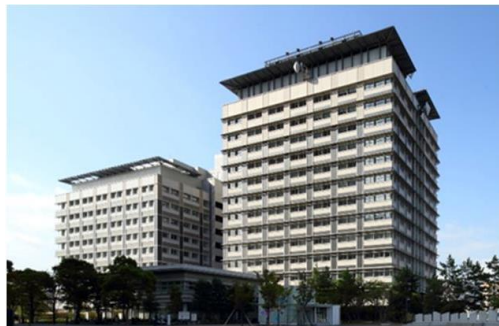
(高松サポート合同庁舎)
