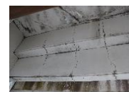
校舎等の天井・壁面 ひび割れや剥離
