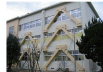
建築物の耐震改修
