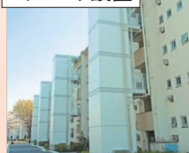
エレベータ設置
