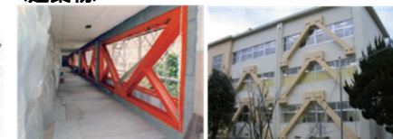
鉄骨ブレースによる壁の補強
