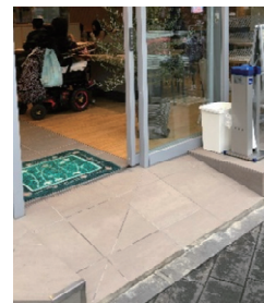
スロープの設置
