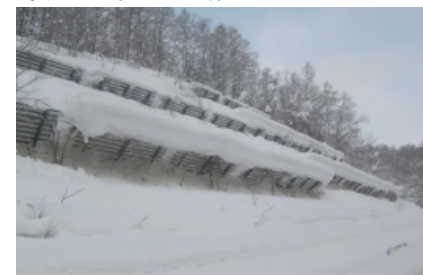
道路斜面における雪崩予防柵設置
