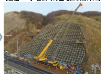
【国道232号 苫前町力屋地区法面对策】
