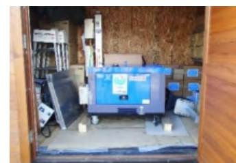
非常用発電設備の設置
