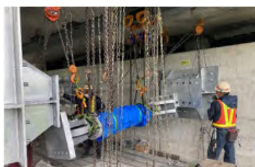
落橋防止装置の設置
