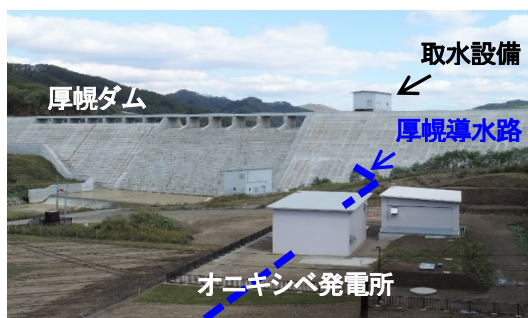
農業用水を利用した小水力発電の例 (厚幌ダム (厚真町))
