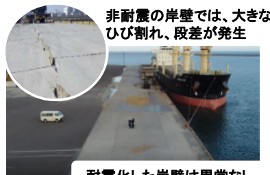
耐震化した岸壁は異常なし
