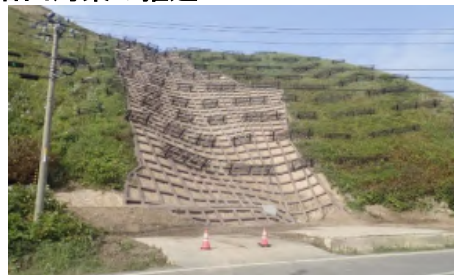
斜面の安定を図る山腹工
