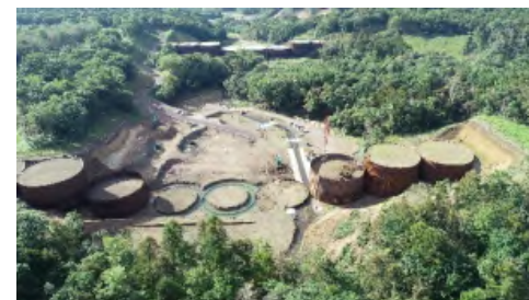
くまのさわ 樽前山熊ノ沢川 3号砂防堰堤（苫小牧市）
