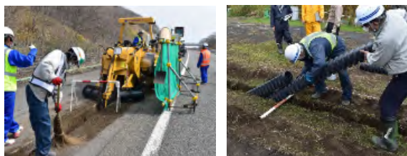
電線類地中化の効率的な施工技術 (トレンチャー掘削)
