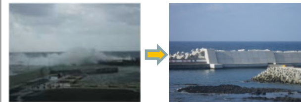
防波堤の嵩上げによる越波対策
