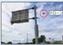
ドローンによる点検 → A I による診断
