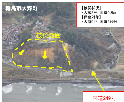
国道249号を寸断した地すべり災害
