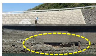
護岸の損傷
