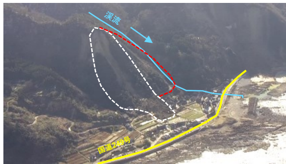
国道249号沿岸部における土砂崩落 (石川県珠洲市)
