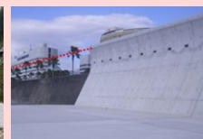
海岸保全施設整備
