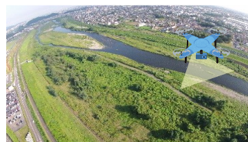
ドローンによる河川巡視
