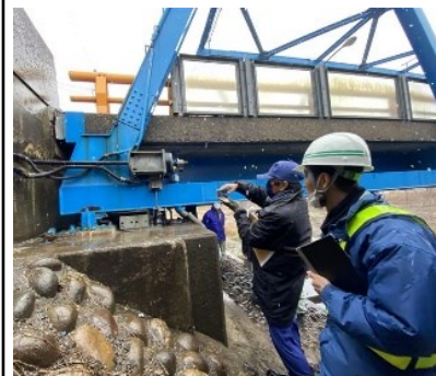
緊急調査状況(富山県新庄川橋)
