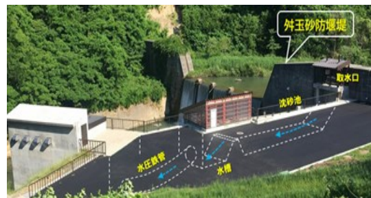
砂防堰堤への小水力発電導入事例
