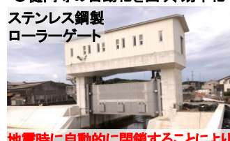
ステンレス鋼製 ローラーゲート 地震時に自動的に閉鎖することにより、 樋門操作の効率化・省人化
