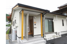
空き家の改修(お試し居住施設)
