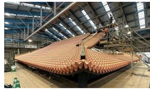
正殿の本体工事（令和6年11月撮影）
