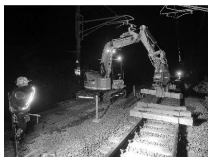
まくらぎ交換の様子
