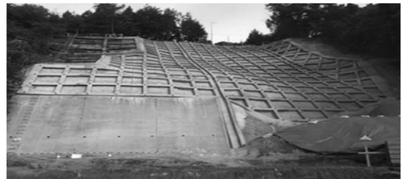
コンクリート枠による斜面の補強
