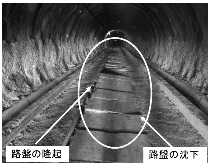
トンネル（先進導坑）の変状
