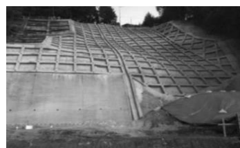
斜面の補強
