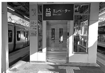
エレベーター
