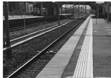
内方線付き点状ブロック
