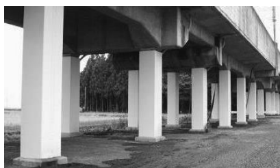
鋼板巻きによる高架橋の耐震対策
