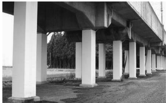
鋼板巻きによる高架橋の耐震対策
