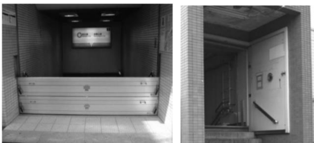
止水板・防水扉の整備
