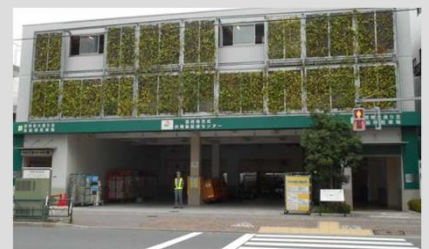
共同荷捌き施設
