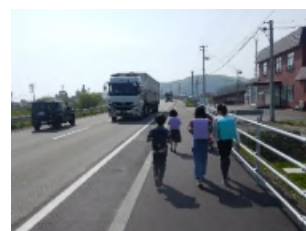
(対策後: 歩道設置)
