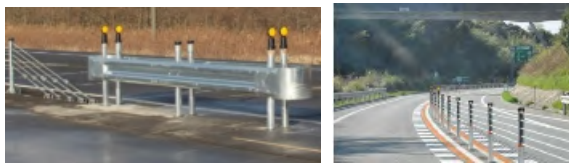
ワイロープ式防護柵の端部衝突対策として開発したガードレール型緩衝装置
