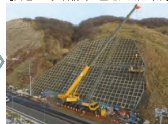
【国道232号 苫前町力屋地区法面对策】
