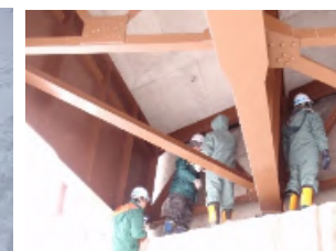
自治体からの要請による 橋梁点検技術支援
