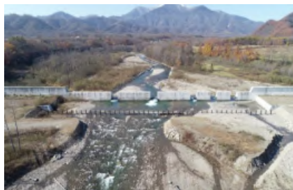
とつたべつ 十勝川水系戸蔭別川 第2号砂防堰堤（帯広市）
