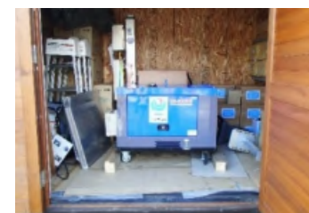
非常用発電設備の設置
