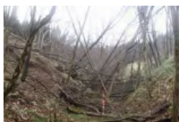
渓岸の侵食や 倒木の堆積が発生
