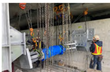
落橋防止装置の設置
