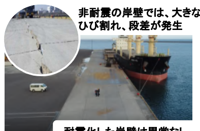
耐震化した岸壁は異常なし
