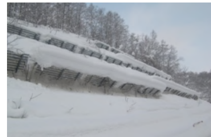
道路斜面における雪崩予防柵設置
