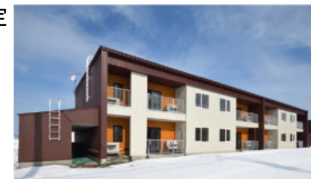
道産木材を活用した公営住宅(栗山町) (構造材及び外壁の一部に栗山町産材のカラマツを使用)
