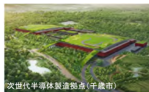
次世代半導体製造拠点(千歳市)
