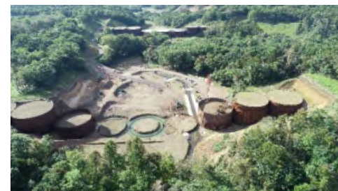
くまのさわ 樽前山麓の沢川 3号砂防堰堤（苫小牧市）
