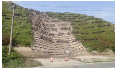
斜面の安定を図る山腹工
