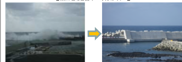
防波堤の嵩上げによる越波対策
