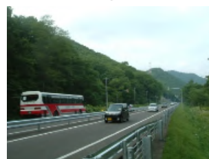
(対策後: 中央分離帯設置)
