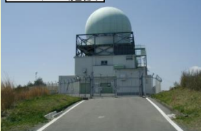
レーダー施設
