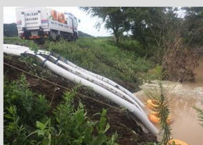
排水作業(町野川) (石川県輪島市)
