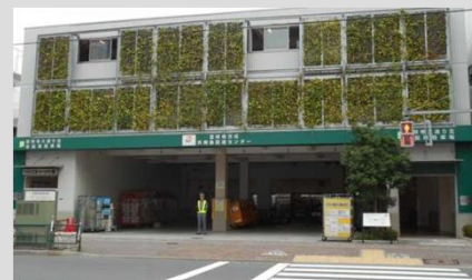
共同荷捌き施設
