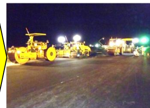
(老朽化した滑走路舗装の改良)
