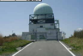
レーダー施設
