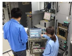
(航空保安施設点検実施状況)
