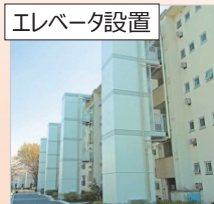
エレベータ設置
