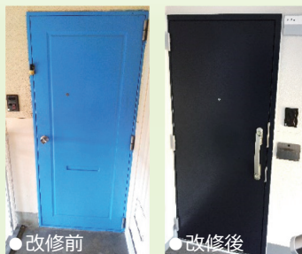
玄関扉の断熱改修
