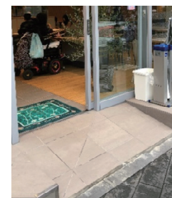
スロープの設置
