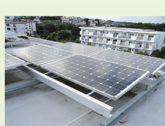
太陽光発電関連設備の設置
