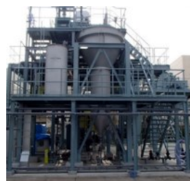
横浜市リン回収施設
