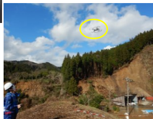
▲ドローンを用いた土砂災害箇所の調査(R6能登半島地震)
