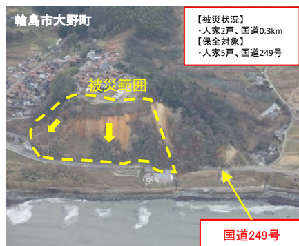
国道249号を寸断した地すべり災害
