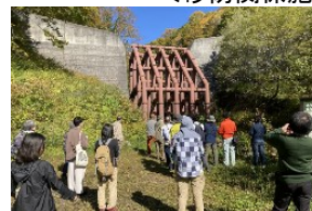
観光連盟主体の砂防ダムツアー 【長野県小谷村（砂防堰堤）】
