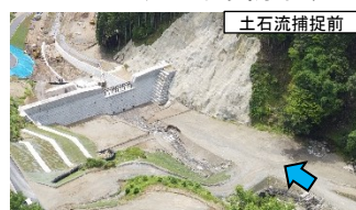
おとし 乙石川上流1号砂防堰堤
