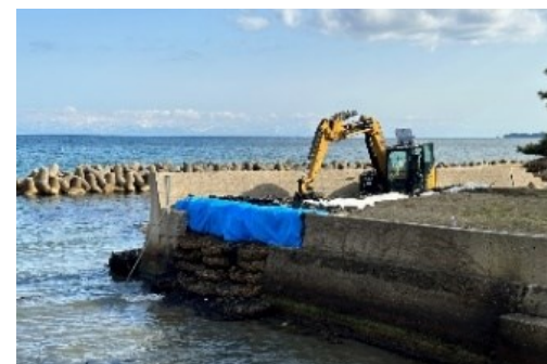
袋詰玉石、大型土のう敷設完了
