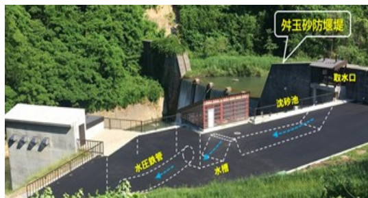
砂防堰堤への小水力発電導入事例
