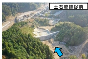
くえんたに 崩谷川砂防堰堤
