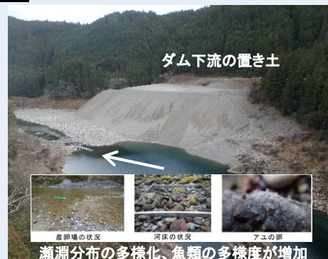
瀬淵分布の多様化、魚類の多様度が増加 土砂還元によるダム堆砂対策と下流河川的环境改善
