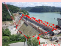
ダム建設・再生
