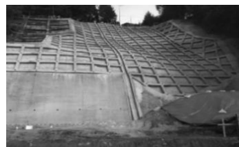
斜面の補強
