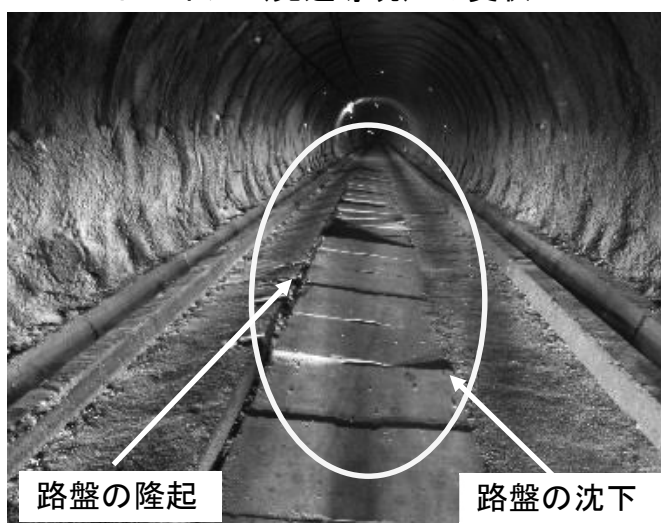
トンネル（先進導坑）の変状
