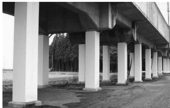
鋼板巻きによる高架橋の耐震対策
