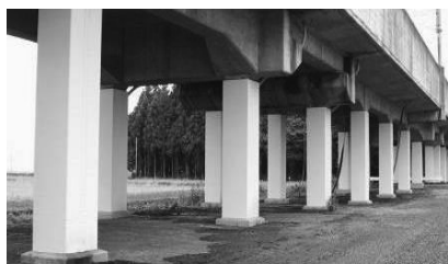
鋼板巻きによる高架橋の耐震対策
