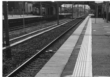
内方線付き点状ブロック
