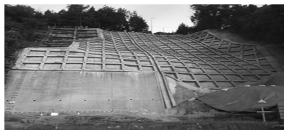
コンクリート枠による斜面の補強
