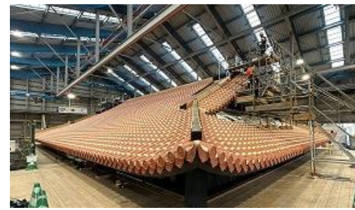
正殿の本体工事（令和6年11月撮影）
