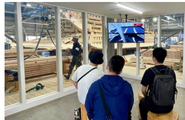
▲正殿工事の様子が見える見学エリア（R5.8～）
