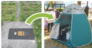
▲ マンホールトイレ
