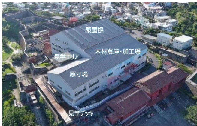
▲首里城の状況（R6.9時点）
