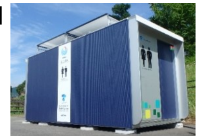
道の駅「うきは」の防災用コンテナ型トイレ（福岡県うきは市）
