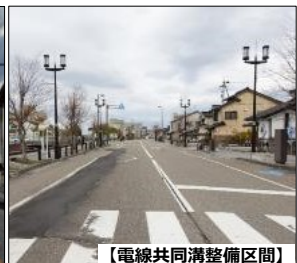
【電線共同溝整備区間】
