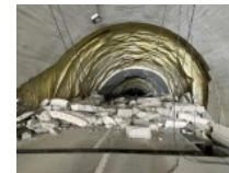
▲国道249号大谷トンネル
