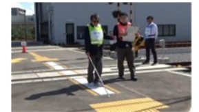
踏切道内誘導表示の整備
