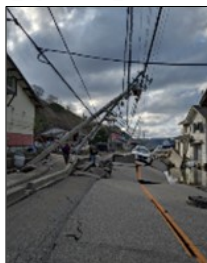
電柱等の倒壊
