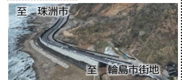
至 珠洲市 至 輪島市街地 海岸隆起を活用し通行を確保 (国道249号千枚田工区)
