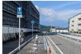
自転車道（大阪府茨木市）
