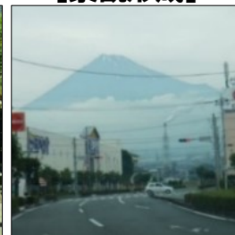
電線類による景観阻害
