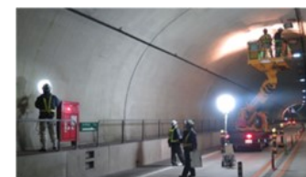
点検状況（トンネル点検車使用）
