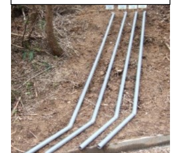
排水ボーリング設置例
