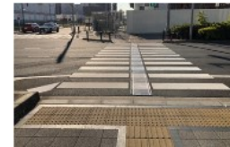
視覚障害者誘導用 ブロックの整備
