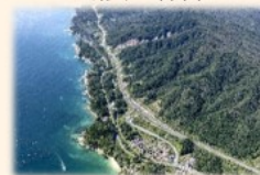
三陸沿岸道路（岩手県山田町）
