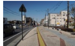
歩道の拡幅・ 段差、傾斜、勾配の改善
