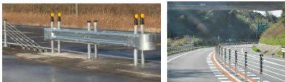
ワイヤロープ式防護柵の端部衝突対策として開発したガードレール型緩衝装置
