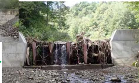
流木や土砂を捕捉し、下流への流出を抑制
