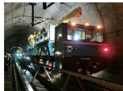
【トロリ線の取り替え状況】
