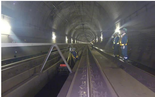
内空変位の測定状況
