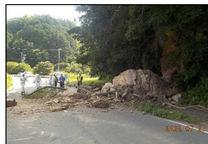
崖崩れによる交通規制の発生
