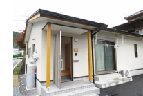
空き家の改修（お試し居住施設）
