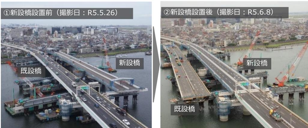
延長約300mの新設橋を既設橋の位置へ移動して架設
