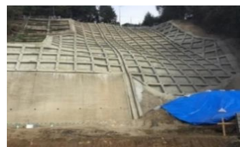
斜面の補強
