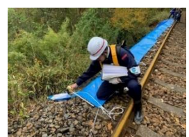
路盤の流出状況の 測定
