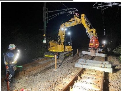
まくらぎ交換の様子
