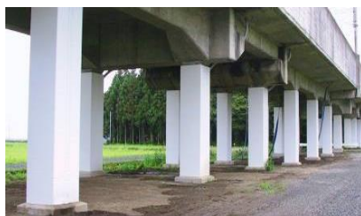
鋼板巻きによる高架橋の耐震対策
