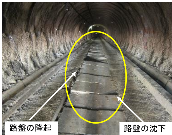
トンネル（先進導坑）の変状
