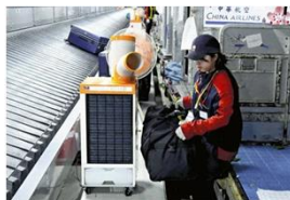
ソーティングエリアに設置されたスポットクーラー
