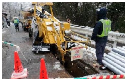
単独地中化工事でトレンチャー掘削を採用
