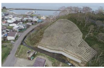
斜面の安定を図る山腹工
