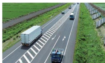
国道337号 道央圏連絡道路 中樹林道路 (R7.3.15開通)
