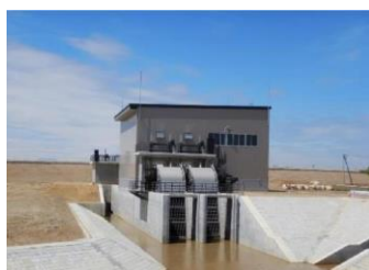
近年の降雨や流出条件の変化等に合 わせて、排水機場の機能を強化。 【江別南幌地区の例】
