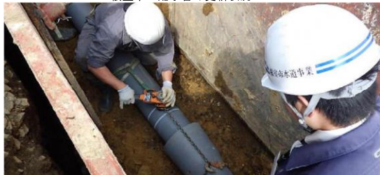
根室市 配水管の更新状況
