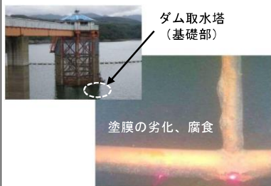
水中ドローンにより不可視部分を効率的に点検。 【真駒内ダム（せたな町）の例】
