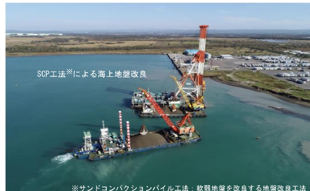
※サンドコンパクションパイル工法：軟弱地盤を改良する地盤改良工法 耐震強化岸壁の整備により地震発生時の港湾機能を維持
