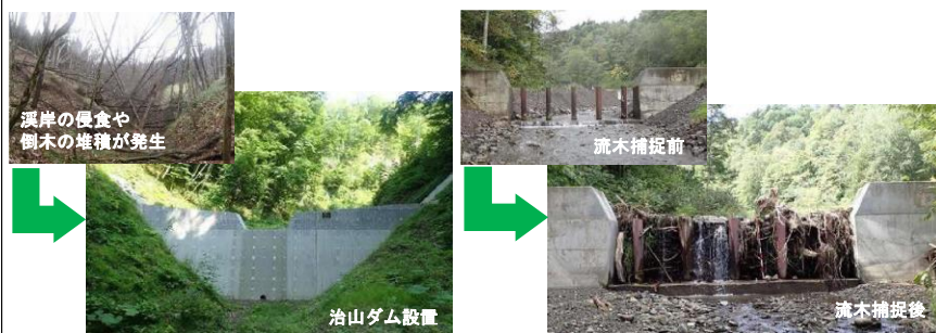
土砂流出を抑制し山地災害を防ぐ治山ダム
