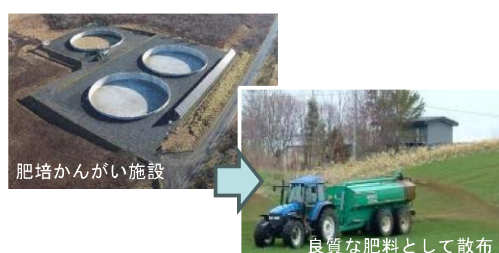
大規模酪農地帯において、家畜ふん尿とかんがい用水を農 地に散布するための施設を整備。
