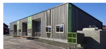
道産木材を活用した公営住宅（下川町） （構造材及び内装材に下川町産材のトドマツ・カラマツを使用）
