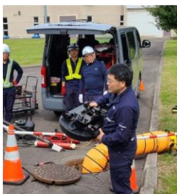
ドローンを用いた下水道管路の点検技術の紹介
