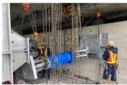
落橋防止装置の設置
