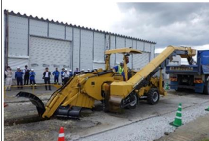
電線類地中化の効率的な施工技術の見学会 (トレンチャー掘削)
