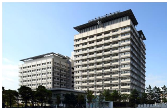
(高松サポート合同庁舎)
