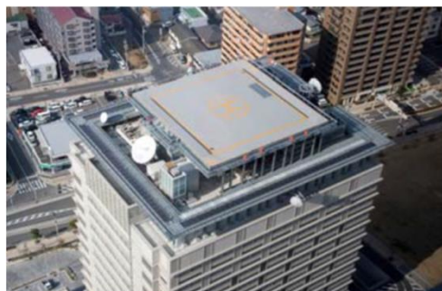
屋上ヘリポート
