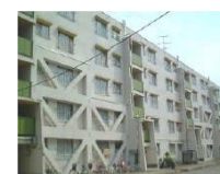
共同住宅 (外付けフレーム補強)
