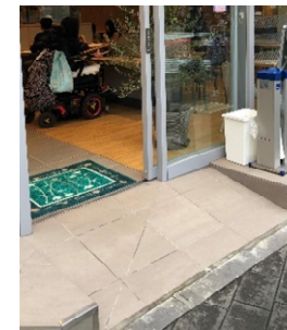
スロープの設置
