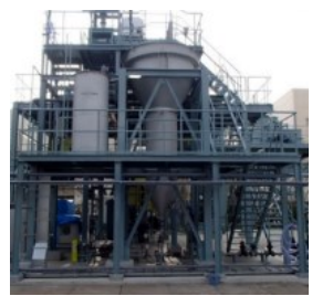
横浜市リン回収施設
