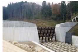
砂防関係施設整備
