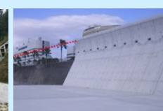
海岸保全施設整備
