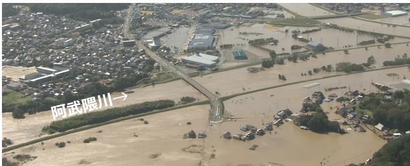
阿武隈川における浸水状況（福島県須賀川市）
