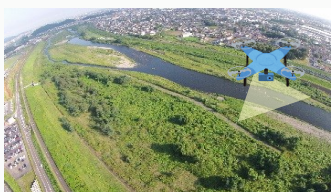
ドローンによる巡視・点検
