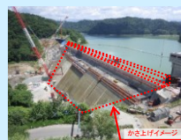
ダム建設・再生
