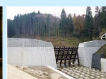
砂防関係施設整備
