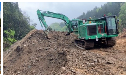
③河道閉塞箇所における遠隔施工実施状況
