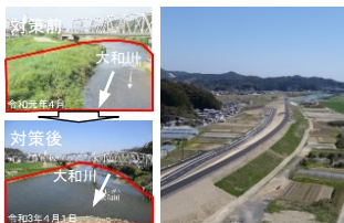
河道掘削・堤防整備
