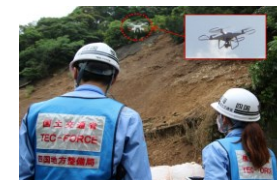
ドローンを用いた 被災状況調査
