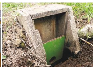
田んぼダム（調整板設置）
