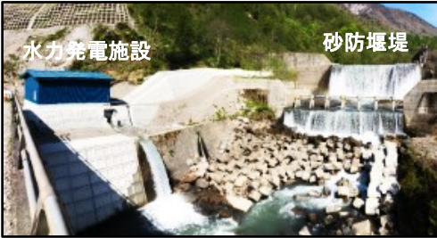
砂防堰堤への小水力発電導入事例(岐阜県高山市)
