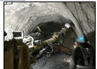
大野導水路 併設水路工事状況
