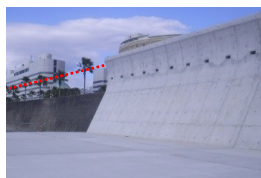
海岸保全施設整備
