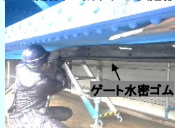
ダムゲートの水密ゴムを点検に基づき適時に交換し、ゲートの損傷を予防(貯水機能を維持)
