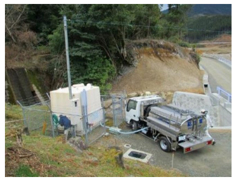
分散型システムの例 (給水車による運搬送水)
