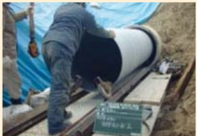
管路の更新・耐震化
