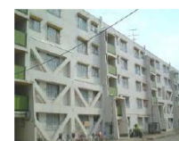
共同住宅 (外付けフレーム補強)
