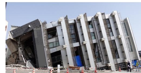
＜能登半島地震により傾斜した大規模建築物＞
