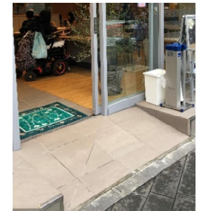
スロープの設置
