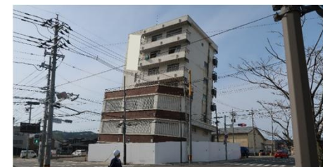
＜能登半島地震により傾斜した大規模建築物＞
