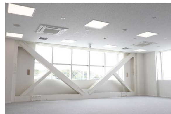
枠付き鉄骨ブレース補強
