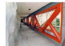
鉄骨ブレースによる壁の補強
