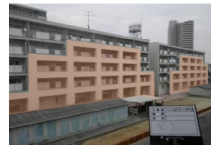
▲外付けフレーム耐震補強
