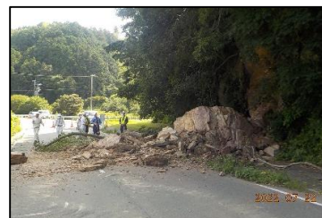
崖崩れによる交通規制の発生
