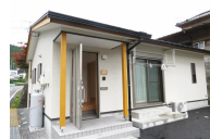
空き家の改修（お試し居住施設）
