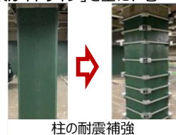
柱の耐震補強
