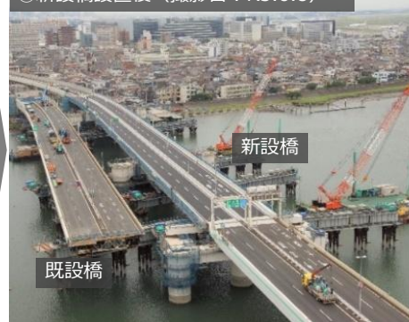
②新設橋設置後（撮影日：R5.6.8）
