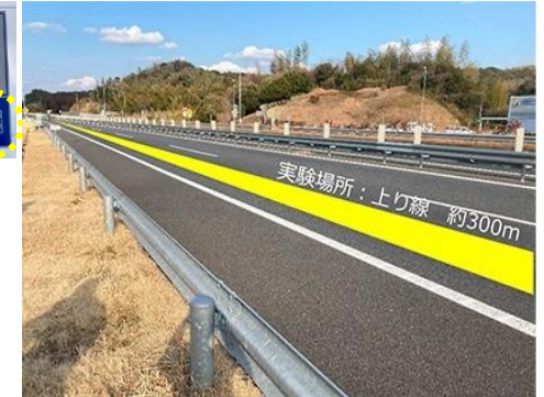
走行中無線給電 実証実験 (NEXCO東日本 館山自動車道)
