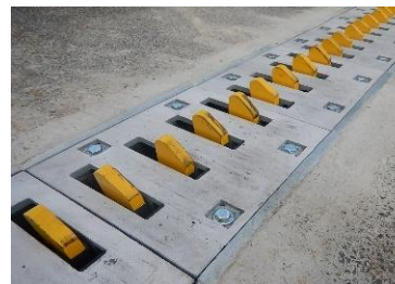
物理的対策 （路面埋込型ブレード）
