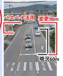
国道3号の交差点改良（大野交差点） バスベイ活用 変更90m 現況60m
