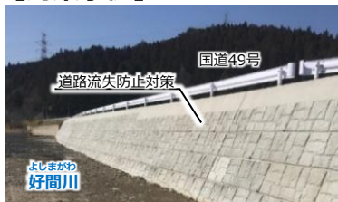
国道49号流失対策 (福島県いわき市)
