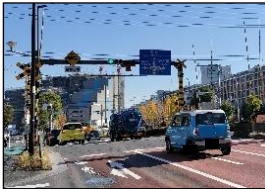
カラー舗装、路面標示
