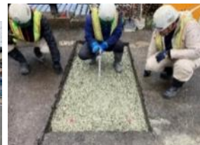
空洞補修工事
