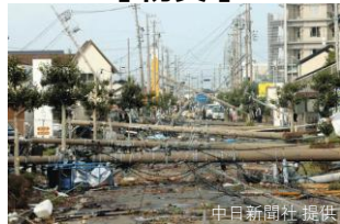
静岡県牧之原市で発生した竜巻による電柱等の倒壊 (R7.9)
