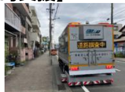
路面下空洞調査
