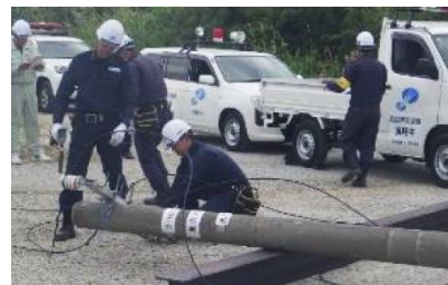
倒壊電柱の除去訓練
