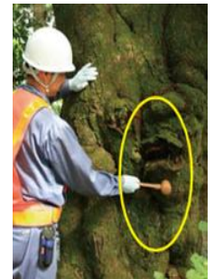
街路樹点検（打音検査）
