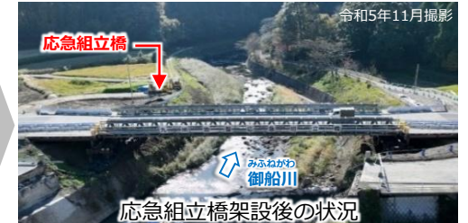
応急組立橋架設後の状況
