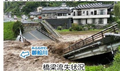
橋梁流失状況
