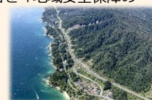
三陸沿岸道路（岩手県山田町）
