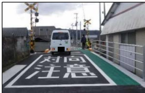
踏切道の歩道設置
