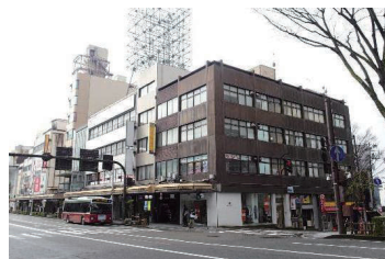
市街地中心部で 更新が計画されている 老朽建築物の例
