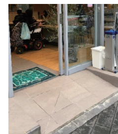
スロープの設置
