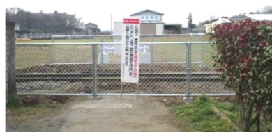
第４種踏切の廃止の例
