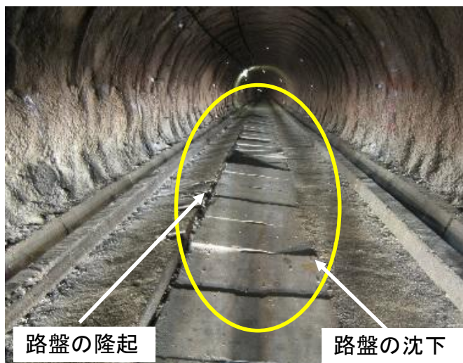
トンネル（先進導坑）の変状
