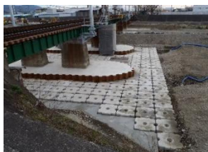
橋脚基礎部の洗掘防止
