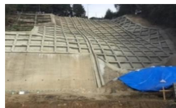
斜面の補強
