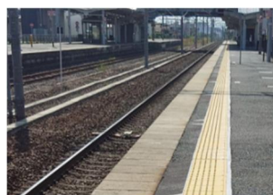
内方線付き点状ブロック
