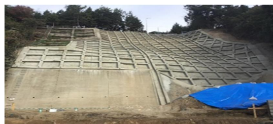
コンクリート枠による斜面の補強
