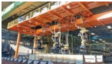
(自動溶接ロボット)
