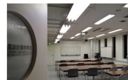
教室や寮における空調設備更新
