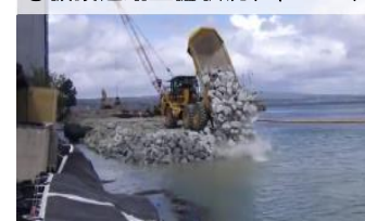
②仮設道路整備状況(3/19~)
