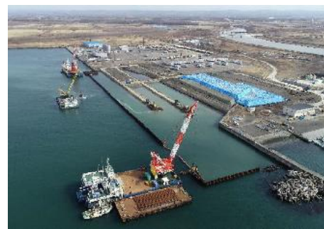
耐震強化岸壁の整備により地震発生時の港湾機能を維持 (苫小牧港)
