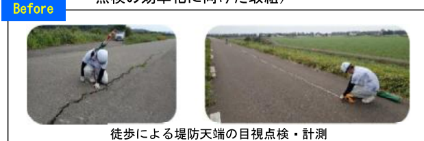
徒歩による堤防天端の目視点検・計測
