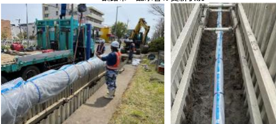
施工状況 写真提供：釧路市
