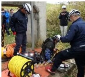
ドローンを用いた下水道管路の点検技術の紹介
