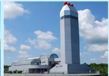
指定避難所整備による地域防災力強化に向けた サーモンパーク施設改修事業（標津町）
