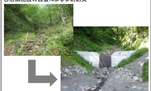
土砂流出を抑制し山地災害を防ぐ治山ダム(愛別町)
