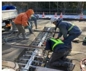
伸縮装置補修
