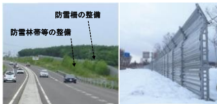
防雪対策の整備状況 (根室防雪)
