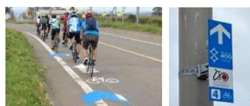
急カーブ前の矢羽根型路面表示、案内看板の設置
