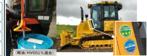
建設機械にバイオ燃料を使用
