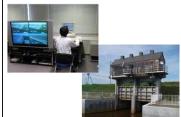
令和7年7月カムチャツカ半島付近の地震に伴う津波警報を受け、樋門遠隔操作システムにより11樋門の閉扉を実施。
