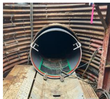
施工状況 写真提供：札幌市
