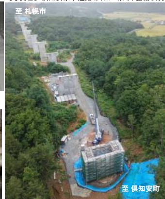
〔写真③〕 俱知安余市道路(共和～余市)整備状況
