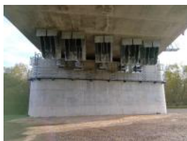
落橋防止装置の整備事例
