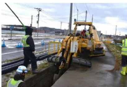
トレンチャー工法を用いた無電柱化の工事状況 (国道231号 留萌市)
