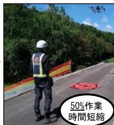
レーザースキャナ搭載 ドローンによる日常管理
