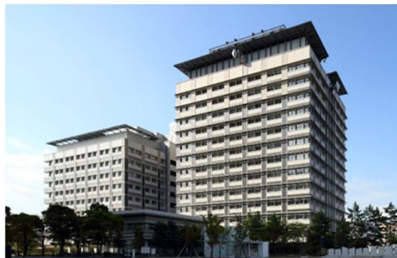
(高松サポート合同庁舎)
