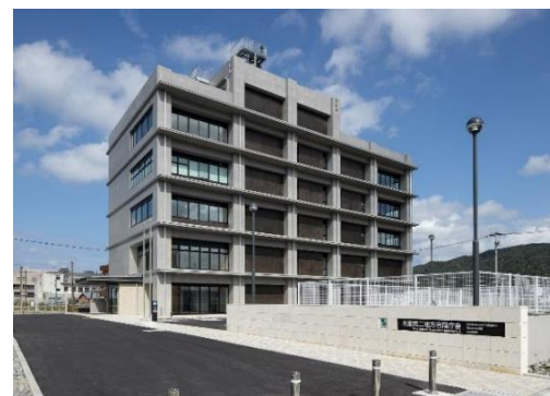
（名瀬第2地方合同庁舎）津波避難ビルの機能を確保
