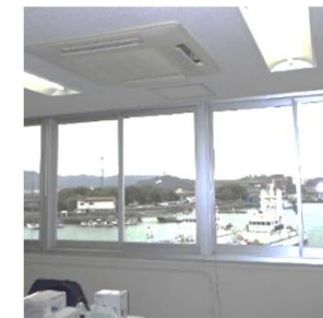
建具（窓枠）の撤去・新設
