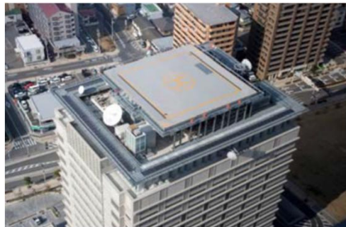
屋上ヘリポート
