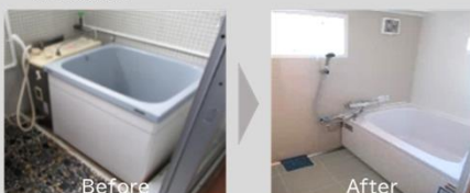
浴室の改修整備
