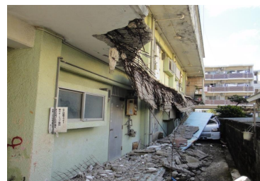
管理が適切に行われずに 廊下が崩落したマンション
