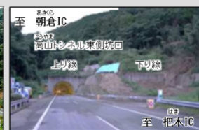
崩落土の撤去
