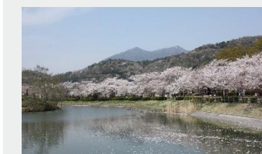
ため池堤防の維持（写真：つくば市HPより）
