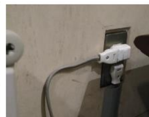
受電部拡大 (上段二股プラグにて分岐、 下段コンセントは既設人形オブジェ用)
