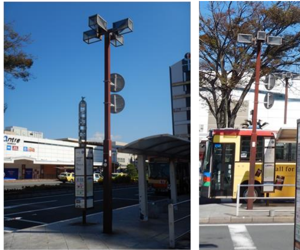
図 6-8 現地調査で撮影した照明施設（防犯灯）
