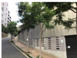
建物の建設 予定地 • 工事中
