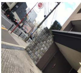
石垣のマンション • 石垣がどんどんたかくなっていて上に植物がある
