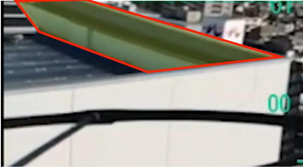
図 4-7 堺地方合同庁舎屋上の「薄壁」(図中の赤枠部分)
