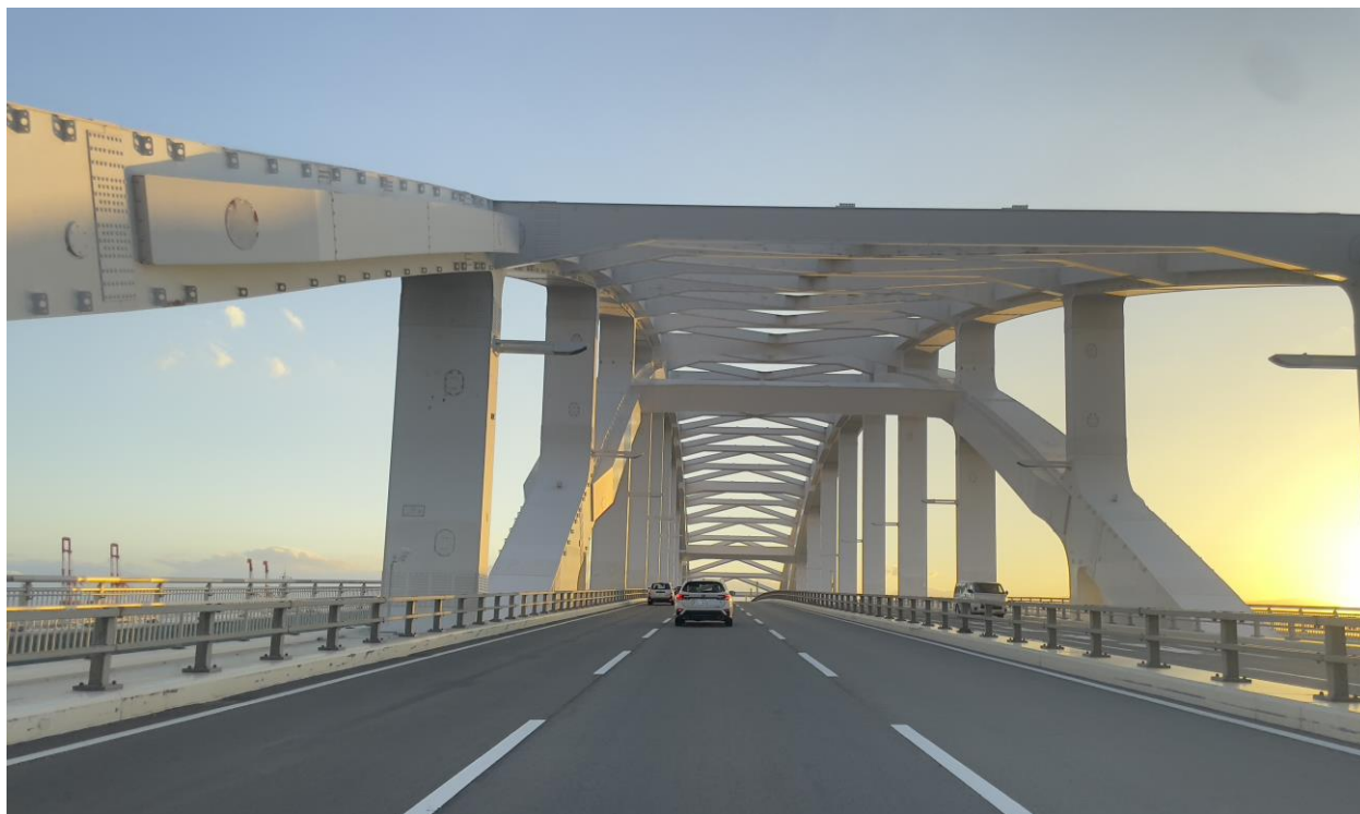
図 4-98 夢舞大橋中央付近 現地の様子
