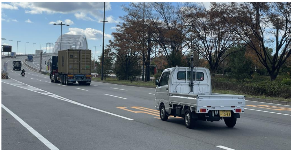
図 4-72 検証用車両 リアルマップを取得するために夢舞大橋を走行する様子
