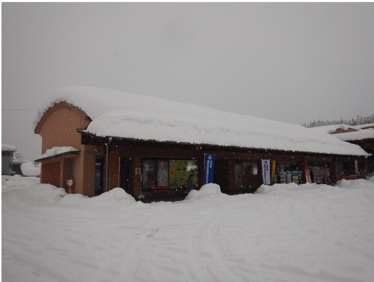
図 9-12 データ提供対象建物の積雪状況 (1月29日 道の駅 R290 とちお)
