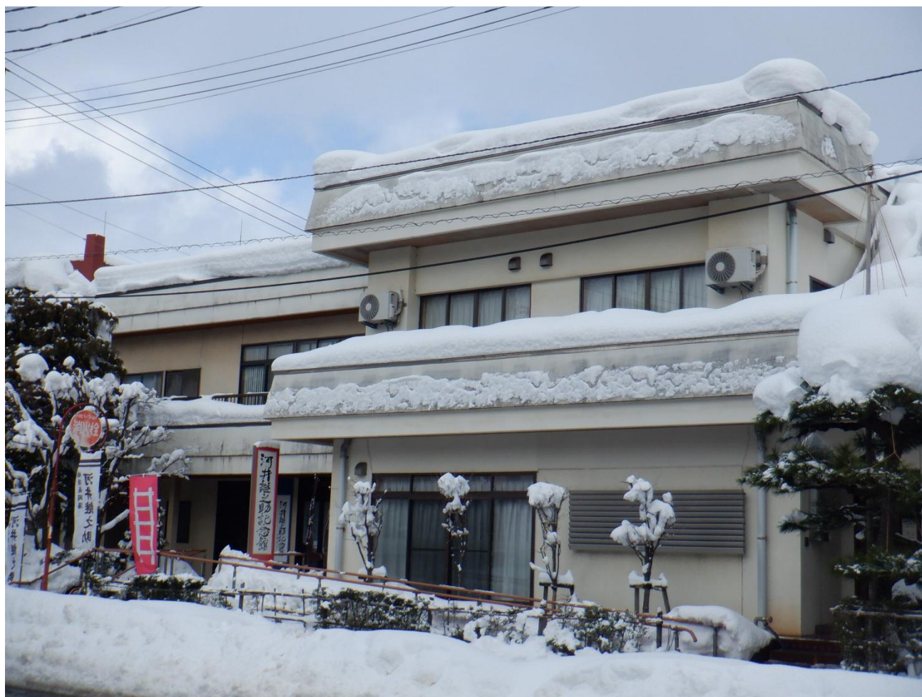
図 9-8 データ提供対象建物の積雪状況 (1 月 30 日 河井継之助記念館)
