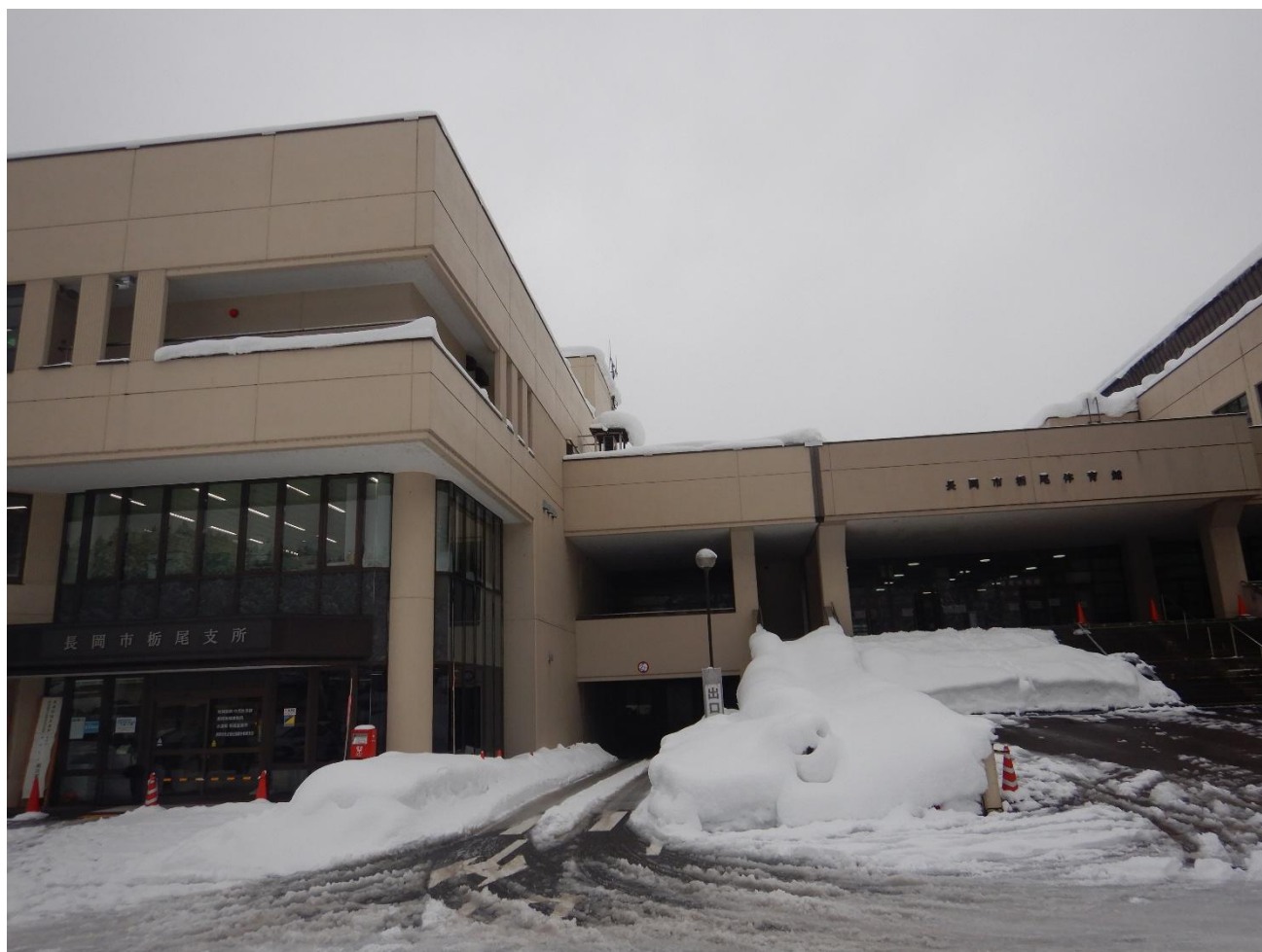
図 9-10 データ提供対象建物の積雪状況（1月29日 長岡市役所栃尾支所）
