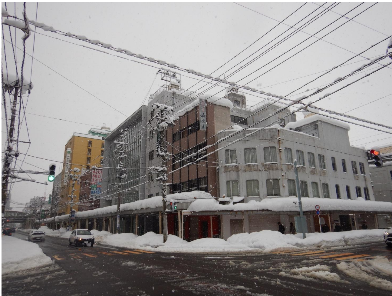
図 9-9 データ提供対象建物の積雪状況 (1月29日 喜京屋ビル)
