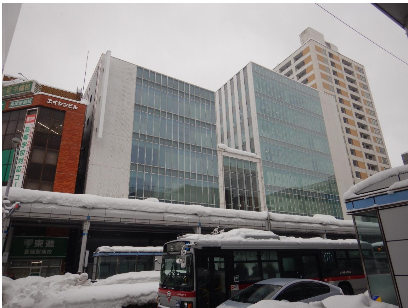
図 9-6 データ提供対象建物の積雪状況 (1月29日 大手通庁舎)
